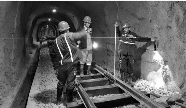
日前,铜冠(庐江)矿业公司组织专人对负800米中段正在施工的铺轨工程进行现场跟踪检查,督促施工单位严格按照规范施工,确保井下铺轨工程在安全的前提下高效优质完成。 朱长华 周贤 摄
