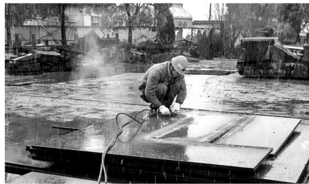
2月8日上午,天空飘起了鹅毛大雪,室外气温寒冷。安庆铜矿机运工区却是一片火热繁忙的景象,维修班钳工、电焊工正在切割、制作盲主井所需要的维修备件。据悉,春节过后,机运工区紧紧围绕矿主井年度方针目标,重点抓提升设备的维修和维护。特别是近期实施的盲主井钢罐道整治项目,在做好并筒作业安全防护工作的同时,积极组织精兵强全力以投入到此项工程,确保整治项目按时保质保量完成。图为电焊工切割制作盲主井维修备件。
