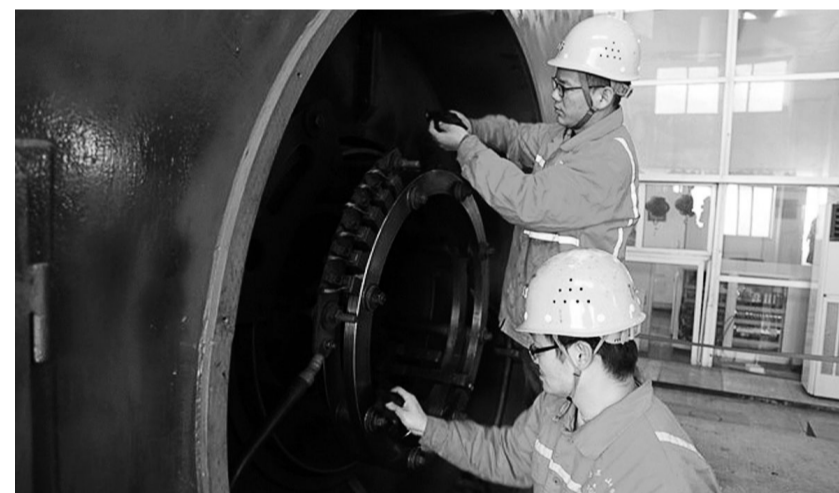
自1月10日起，冬瓜山铜矿年初检修工作全面展开，检修项目达130余项。尽管存在难度大、时间紧、任务繁重等诸多困难，但广大职工顾全大局，加班加点，坚守在检修现场，力争安全高效地夺取这场检修攻坚战胜利。
