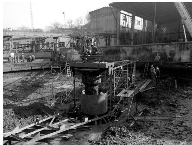
经过全体检修人员9天的不懈努力,凤凰山矿业公司选矿车间24米铜浓浓机的更新施工工作已全部按计划完工。图为维修人员正在组装桥架、行走机构及搅拌装置上部各件、刮泥耙、控制柜及附件。
