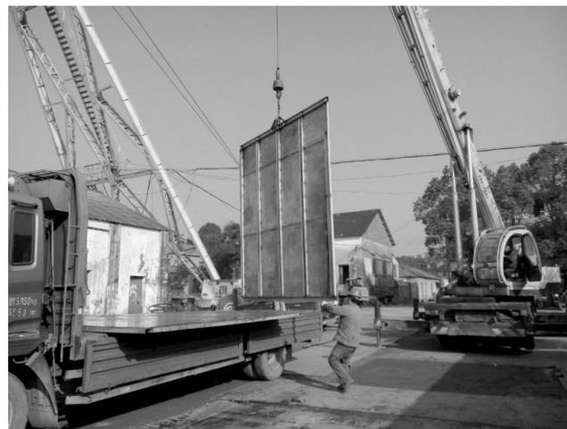
铜山矿业公司针对铁质风门易受井下硫磺烟腐蚀,而影响各用风地点的通风质量,通过将铁质风门改为不锈钢材质,不仅大大降低了维修率,优化了通风系统,保障井下正常通风,还提高了安全和经济效益。
