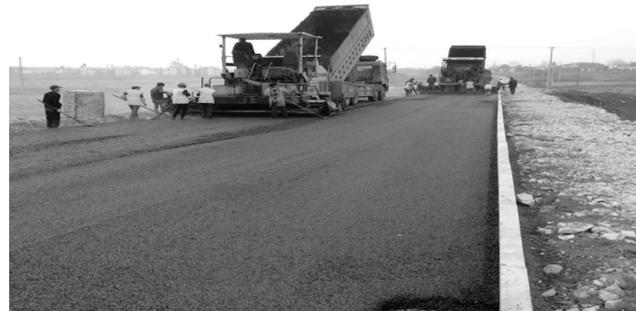
日前,由铜冠建安合肥分公司承建的安徽铜冠(庐江)矿业公司有色大道青面层建成通车。据悉,有色大道全长1200米,为双向两车道9米宽,两边是人行绿道,路面设计为沥青砼面层。该路外接合铜公路,内联矿区,通车后极大方便了人员及车辆进出矿区。图为正在摊铺施工沥青砼。毛文文 摄
