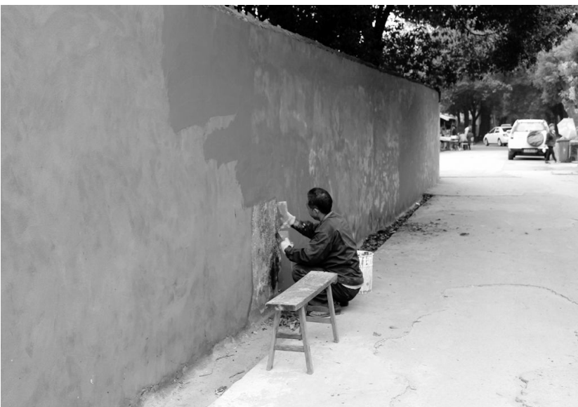
近日,一名工人师傅在铜冠物流金铁分公司工务段小机关外围墙一侧墙面涂刷水泥。该围墙旁的惟一条小路是连接金铁分公司职工上下班及附近金山村部分居民出行的通道,由于外围墙常年日晒雨淋造成墙面破损,影响美观。为加强文明单位创建工作,金铁分公司安排专项资金用于修补,经过 2 天的全面整修,原本破旧的墙面换上了新装。
