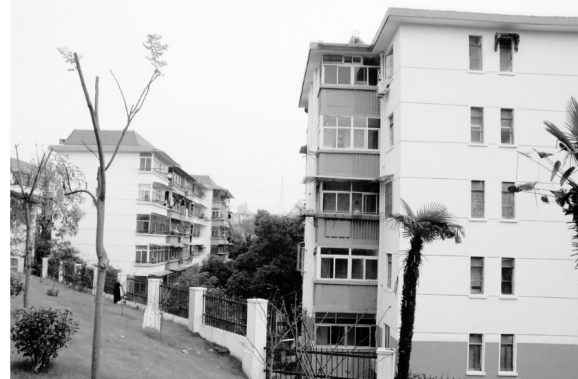
“昔日灰太狼,今朝俊姑娘”。这是天井湖社区天桥新村居民对改造后的天桥新村变化的形象比喻。据悉,由市住建委牵头实施的我市纳入包括天桥新村十个省民生工程老旧小区整治改造工程目前全部完成。12月1日,记者看到,整治后的天桥新村(东段)20栋6层住宅楼整体变得亮丽光彩(如图),如同新盖的一样。
