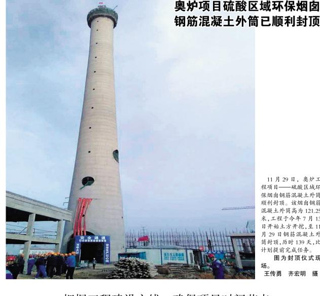
11月29日, 奥炉工 程项目——硫酸区域环 保烟囱钢筋混凝土外筒 顺利封顶。该烟囱钢筋 混凝土外筒高为 121.25 米,工程于今年7月13 日开始土方开挖,至11 月29日钢筋混凝土外 筒封顶,历时139天,比 计划提前完成任务。
