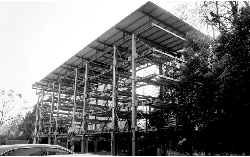
11 月 28 日晨，记者看到，位于天井湖公园东门内的滨湖路停车场扩建工程——立体智能停车楼建成（如图），并将于 12 月 1 日交付使用。据悉，这座停车楼内可停 40 辆车，实行自动停放，据城建部门有关负责人介绍，这是我市计划建设的 5 座立体停车楼中首座建成的，可缓解天井湖公园入口区停车难的问题。
