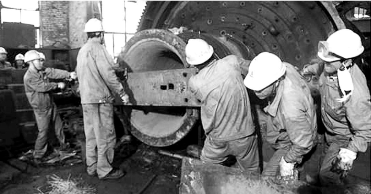
由铜冠建安安装公司承接的安庆铜矿磨浮车间 2 号球磨机大修，即 2 号球磨机轴瓦更换轴承大修工程已于 11 月 16 日正式打响。此次大修任务时间紧、任务重，需要在 7 天时间内完成，且作业现场空气不畅通、作业时间长、劳动强度大、作业场地不规整。为了确保该工程安全高效完成，该公司从金隆、沙溪等项目上抽调人员，一次性调入了 21 名各主要工种施工人员进行驻场施工现场，采取两大班施工、连班加点进行作业。图为该公司技术工人正在对球磨机出料筒进行拆卸。
