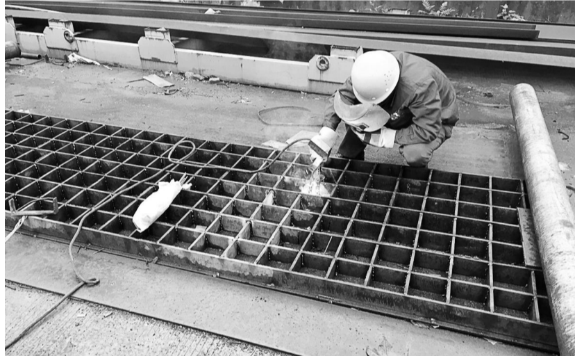
天马山黄金矿业公司充填工区大力开展降本增效活动,员工主动将10毫米厚的钢板制作成缓冲仓格栅,避免了到厂家采购,仅此一项节约成本近万元。图为电焊工正在制作格栅。 夏富青 齐卫东 摄
