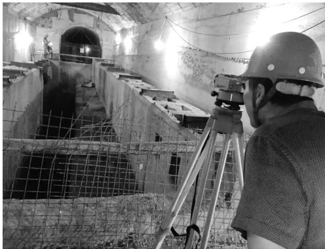
一直以来,安徽铜冠(庐江)矿业公司盯紧工程质量不放松,要求施工单位严格按照质量标准进行施工,确保工程质量不打折扣,项目建设有序推进。图为卸矿仓施工现场,技术人员正用水准仪进行校准,为下一步托滚和曲轨的顺利安装打好基础。 汪海滨 摄
