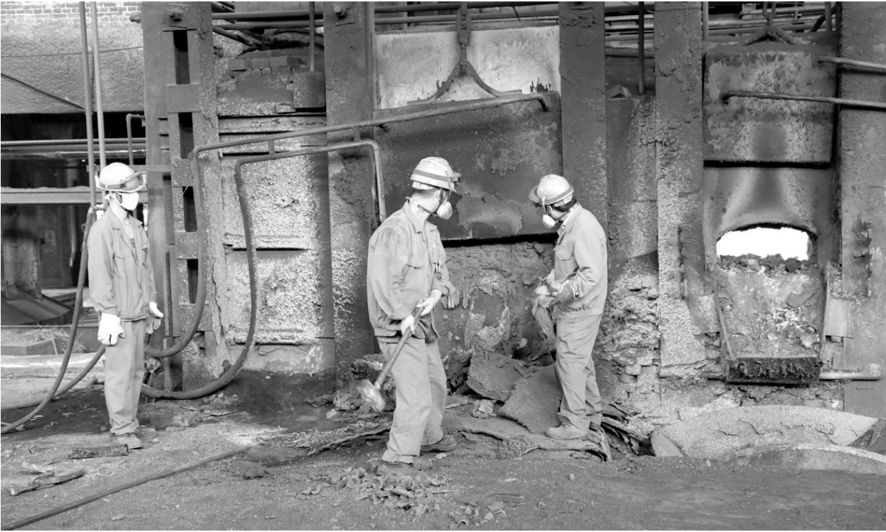
金昌冶炼厂熔炼车间转炉班职工日前正在拆炉口。为加强转炉日常维护工作,熔炼车间十分注重维护好炉衬和炉口,在强化转炉平稳操作,保持正常炉温,减少炉衬的化学腐蚀的同时,狠抓打炉口重要环节,安排专人指挥,杜绝人为损坏炉口砖衬,并及时搪好黄泥,保证下炉口的平整,全力确保转炉正常运转。
