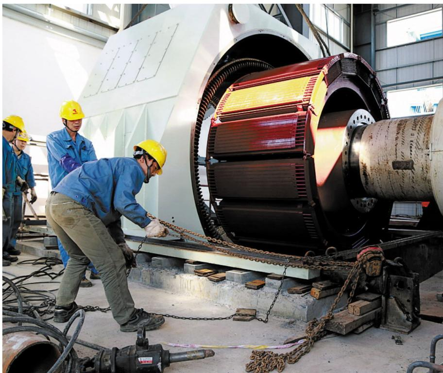
10月10日,铜冠建安安装公司施工人员在沙漠项目工程中吊装主井卷扬机定子。铜冠建安安装公司此次吊装的定子,是其承担的沙漠项目主井卷扬机安装中的最后一个大件设备,设备重达55吨,吊装施工需要将定子套在转子上。当日,该设备成功安装到位,标志着主井卷扬机主设备全部安装到位,下一步将进入卷扬机调试阶段。王红平 陈致生 摄
