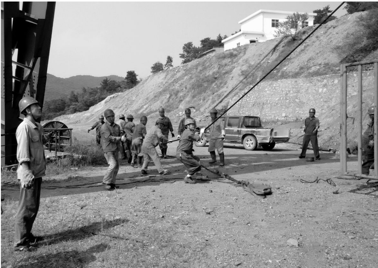
9月16日,仙人桥矿业公司在节假日期间组织精干人员,对点检过程中发现断裂的提升钢丝绳实施抢修更换。该公司组织二十多名员工从当日中午开始对主井箕斗钢丝绳更换,连续奋战五个小时,终于安全顺利地完钢丝绳更换工作,保证了公司的连续生产。
