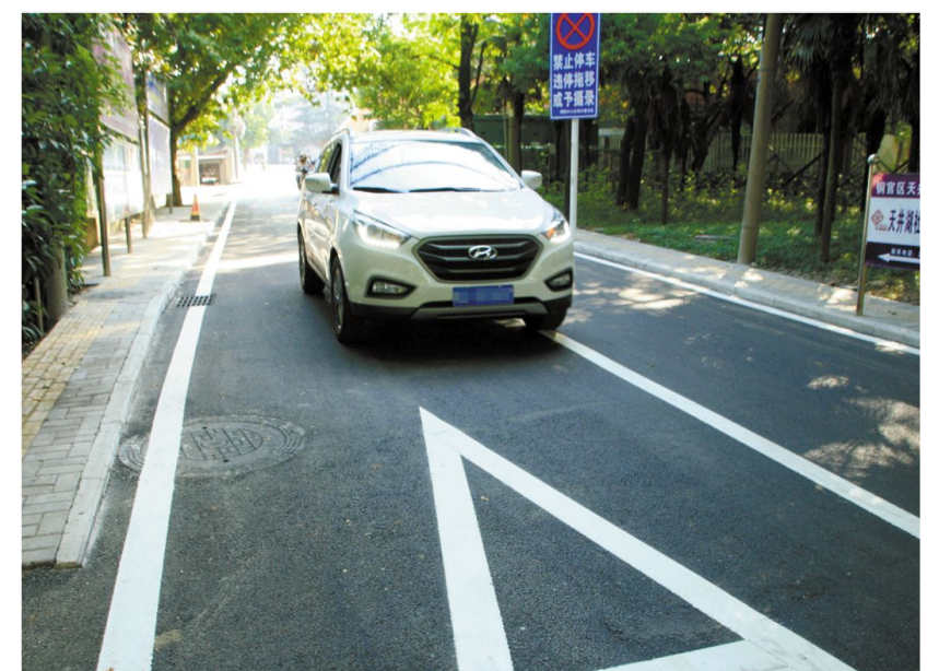
“有色二路修得好,加宽取直添盲道。停车位标准化,社区居民齐点赞。”这是有色二路8月26日的通车后,离休老干部张甲鼎编的顺口溜。据悉,连接长江西路与滨湖路、全长560多米的有色二路多年来坑坑洼洼,通车条件较差。7月底,市住建委投资180多万元对此路进行彻底改造,如今,这条路被称为铜管社区内的标准路,市民路过此路,纷纷称赞此路修得好! 殷修武 摄
