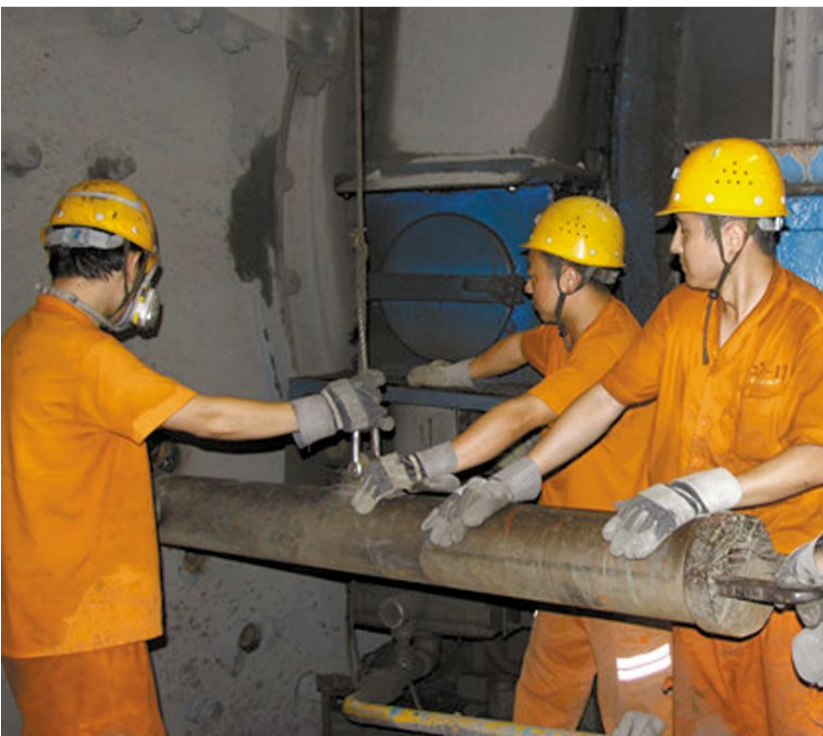
连日来烈日炎炎,冬瓜山铜矿无论是地表还是井下,广大职工在各自的工作岗位上默默坚守,与高温作战。日前,这个矿选矸车间对半自磨机、球磨机等大型设备进行检修(如图),尽管磨机和浮选槽内部温度达到60摄氏度,但检修人员克服高温恶劣环境,安全高效完成所有检修项目。 汤菁 摄
