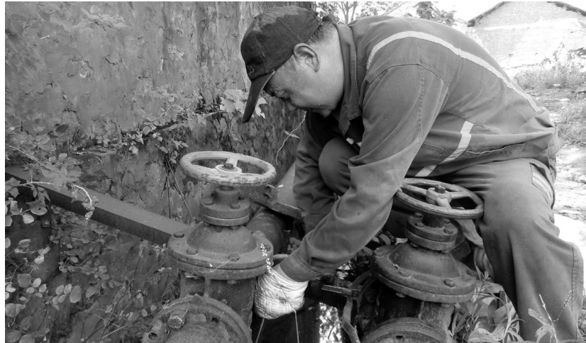
7月29日,铜山矿业公司室外气温高达41摄氏度,该公司尾矿库的维修工小花仍然冒着高温坚持在排查管道。为了保障生产正常运行,该公司广大干部职工依然坚守在生产第一线,接受着高温天气的“烤”验。 江 君 张 霞 摄
