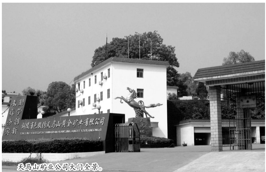
天马山矿业公司大门全景。
