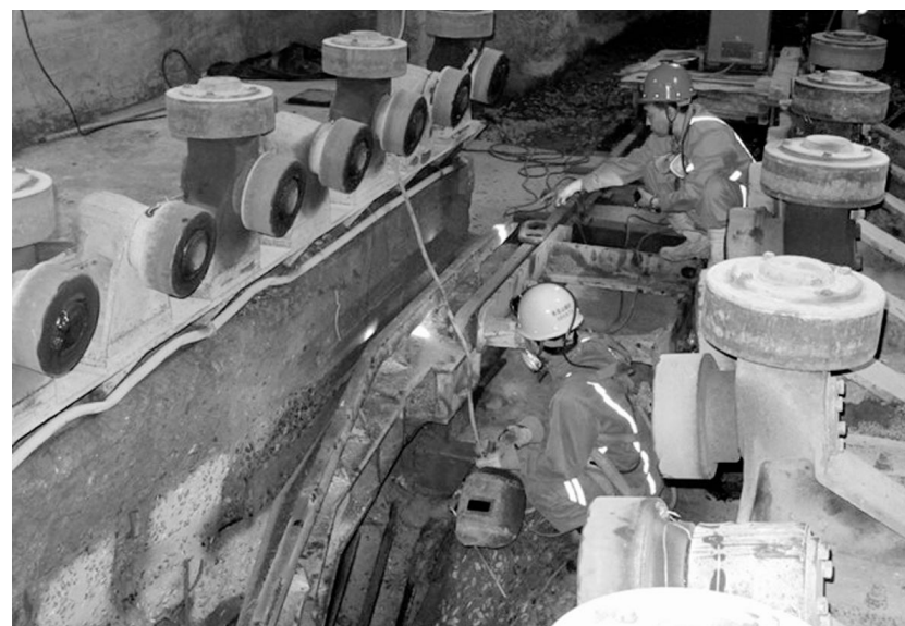
冬瓜山铜矿运输区730米中段的矿石仓是井下卸运矿石重点中转站之一，由于电机车运输矿石任务繁重，工作负荷较大，其矿仓滑道磨损较重。日前，该矿大团山区积极动脑想办法，将更换的旧轨道面，经过剪裁铺设在滑道上，进行人工堆焊加厚（如图），此举不仅延长了矿仓滑道使用寿命，也降低了生产成本。 徐志勇 摄
