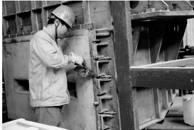
铜冠铜棒材公司熔铸车间职工日前正在保养保温炉。该车间熔铸生产中保温炉耐火面板易碎,经常需要更换,但更换面板费时费力费钱。车间积极采纳职工提出简化面板更换步骤的合理化建议,使得在不停炉的情况下,可以更换保温炉面板,不仅大大缩短了更换时间,还节省了吊装、烘烤等费用,仅此每年可减少更换面板综合费用达百万元。该项建议日前获得安徽省重大合理化建议和技术改进成果项目奖。 王红平 汪勇 摄
