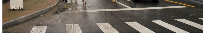
长402米、路幅宽25米、造价533万元的长江二路东段工程,经过60天的施工,于5月25日全线建成通车(如图)。长江二路东接笔架山路,大大缓解了主城区多条交通要道的交通压力,更加方便了市民的出行。 殷修武 摄
