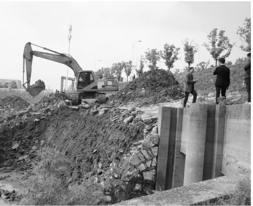
4 月 28 日上午,笔者看到位于滨江大道、滨湖支路、后冲路与长江西路合围区域、占地约 185 亩的黑沙河下游岸线整治三期工程工地上,挖掘机正在紧张进行土方挖掘作业(如图)。据现场工作人员介绍,我市这项今年的重点工程是作为海绵城市示范工程,计划工期 180 天,改造竣工后,这里将成为海绵城市示范工程、园林绿化亮点工程和连接滨江与城区的生态绿廊工程。
