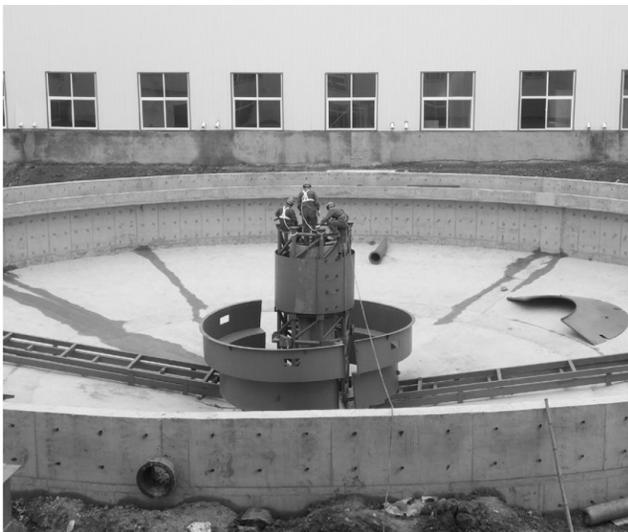
4月5日,铜冠(庐江)矿业公司选矿厂铜、铁浓密机开始安装(如图)。铜浓密机直径为30米,铁浓密机直径为18米,两者传动方式均为中心传动式。设备厂家技术人员和施工人员正在施工现场加班加点进行安装,争取早日完成浓密机的安装任务。
