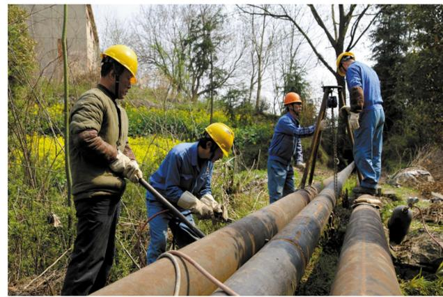
安庆铜矿对途经深长达3100余米受到严重侵蚀的尾矿管进行更新改造。为了使工程保质保量地尽快完工,参与管改的职工们每天加班加点地工作。新管改更新后确保生产顺畅,进一步优化沿途环境质量。
