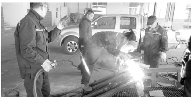
铜冠物流金属物流分公司运用多种方式,坚决纠正“人”的不安全行为,全面推动职工的安全意识实现转变,同时加大消除“物”的不安全状态力度,积极落实隐患整改。驻安徽铜冠有色金属(池州)有限责任公司装卸现场的叉车专用登车桥因使用年限较长,多处脱焊、变形,存在安全隐患。日前,分公司请金铁分公司技术人员利用周末的发货间隙,对登车桥进行维修。 汪开松 摄
