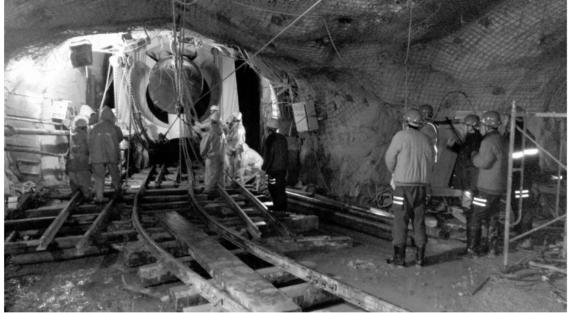
元宵节前夕,铜矿新建公司机电安装分公司历时 5 天,顺利完成沙漠主井破碎系统大件下放工作,将破碎机以及桁车下放到负 850 米平巷,提前一天完成工程节点安排。
