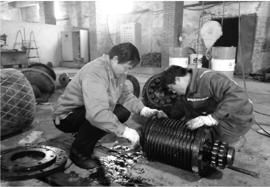
2 月 24 日,铜山矿业公司码头分公司员工正在修复内置式皮带电柜(如图)。该公司克服主、副产品价格低位的巨大经营压力,自我加压,提出全年挖潜降耗、增收节支 3500 万元目标,以确保矿山在市场经济低谷时期的可持续发展。 夏富青 摄
