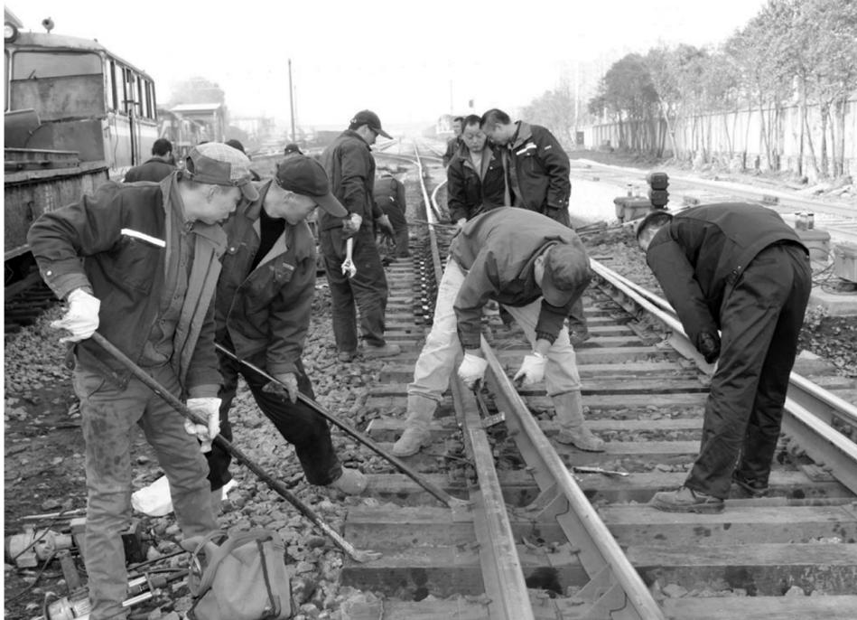
春节长假刚刚结束,铜冠物流金铁分公司立即召开“醒酒会”,布置节后各项工作,使全员尽快投入到运输生产中。图为2月17日上午,该分公司工段10余名线路工会同电气信号工,正在余家村铁路站场更换一根长12.5米带有裂纹的基本钢轨,及时处理安全隐患。 邹卫东 摄
