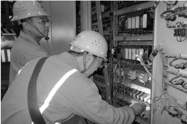
针对连日来的雨雪低温天气,冬瓜山铜矿选矿车间开启设备“低温保护”模式,对各药剂管道、生产水管及风管采取保护措施,对电气仪表设备进行检查维修,各液压站的进出油管、轴瓦油封进行检查或更换,确保设备润滑传动部位在低温下正常运行。图为该车间维修人员正在维护电机温控系统场景。 **高明 摄**
