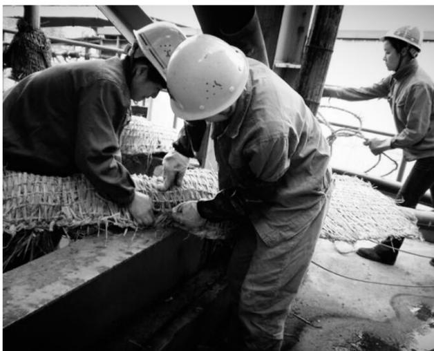
凤凰山矿业公司选矿车间高度重视冬季设备防寒工作,从人防、物防、技防入手,确保设备安全、稳定、高效运行。图为该车间员工对裸露在室外的管道用草包进行缠绕包扎。
