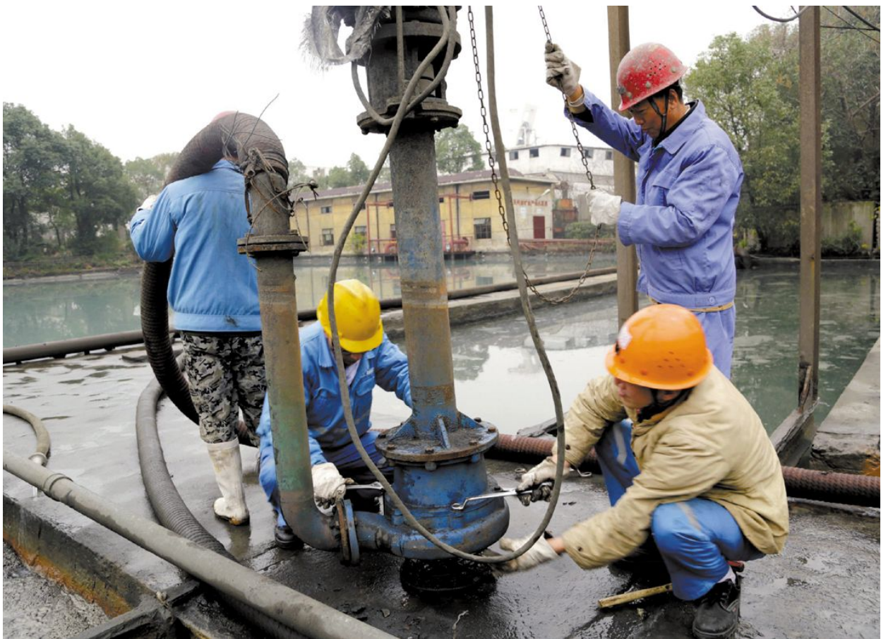
日前,安庆铜矿管道维修人员正在对万吨循环水池吊泵进行定期维护。据了解,安庆铜矿对生产用水进行技术处理后循环使用,既防止了污水外流,又节约了很大一笔生产成本,实现了环保效益双丰收。 杨勤华 摄
