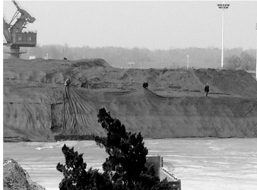
日前,铜冠物流金园分公司为抑制港区扬尘,特别是针对堆场和道路尘土对环境造成的污染,在完善装卸标准、港区内车辆管理要求等制度的前提下,通过设置车辆进出港区清洗槽、港区内不间断洒水等措施降低扬尘。近期,港区制定了货场覆盖相关规定,对存放期达到一定期限的货物进行全覆盖。在满足环保的要求下,也为降低货物损耗提供了保证。陈玲璐 摄
