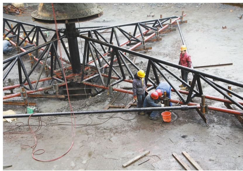
12月24日,天马山矿业公司维修技术人员正在选矿车间浓密池内检修作业。为确保明年整体生产达到“降耗节能,安全稳定运行”,更好的完成生产经营任务,天马山矿业公司从12月15日开始组织开展了为期15天的年度系统检修。选矿车间作为矿业公司地表重要检修单位,为确保按期完成检修任务,组织车间职工积极配合维修技术人员同步在浓密机、陶瓷过滤器、浮选机、球磨机各个作业点展开了检修作业。
