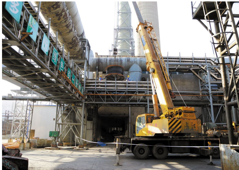
12月17日，铜冠建安安装公司施工人员正在金隆公司厂区铺设电缆。安装公司自8月份进场安装以来，通过精心组织，施工进度按照了工程节点稳步推进，目前，施工进入了扫尾阶段的电气安装。 王红平 舒 婷 摄
