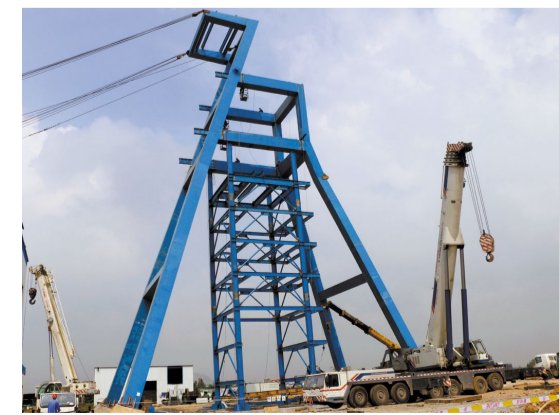
沙溪铜矿项目地处安徽省合肥市庐江县泥河镇,设计生产规模为年采选330万吨,服务年限为21年。该项目于2010年开始建设,项目建设的投资17亿元,预计2016年建成投产。截至目前,累计完成投资15.04亿元,井巷掘进完成48万立方米,五条竖井全部成井到底,各硐室掘进按计划进行,井下各中段已基本贯通,副井提升系统安装基本完成,地表供电系统已建成投入使用,选矿系统全面开工建设,主要设备已安装到位,尾矿库建设现进入坝基清表作业阶段。该项目建成投产,将提升集团公司铜精矿自给水平。
