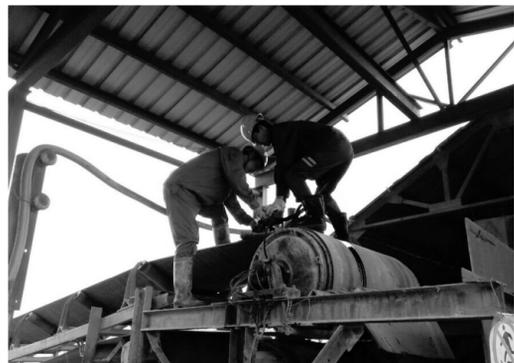
10月26日,铜山矿业公司码头分公司对皮带滚筒进行加油保养。该分公司利用矿产品发运停歇时机,对皮带磨损刮板、格筛等及时更换,并对运转设备进行加油保养,确保设备高效运行。 夏富青 摄
