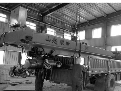
日前,铜冠(庐江)矿业公司脱水车间陶瓷过滤跨电动5吨单梁行车安装完毕,单梁行车安装完成标志着沙溪铜矿脱水车间进入到设备安装阶段。图为施工人员正在做行车运送前的准备工作。 王树辰 蒋维海 摄
