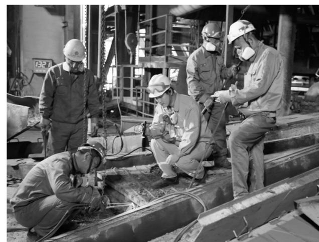
金冠铜业分公司2015年度检修工作于10月18日拉开帷幕,此次检修计划安排390项,涉及343项外协项目及47项自修项目。该公司以“保安全、保质量、保工期、保费用”的“四保”目标全面布置,保障检修工作按计划完成。图为技术人员正在检修现场指导检修人员拆除闪速熔炼炉水套。
