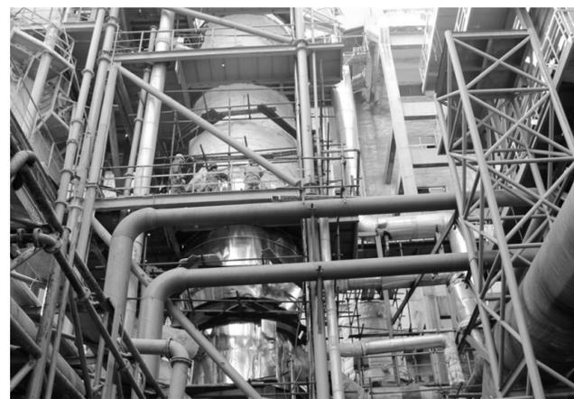
日前,铜冠冶化分公司完成球团脱硫脱砷塔扩能改造项目。据了解,为优化球团脱硫技术经济指标,降低脱硫运行成本,该公司对现有脱硫脱砷塔进行扩能改造,通过优化空塔流速、采用改型填料、新增胺液回收装置等措施,提高解吸塔解吸能力,降低脱砷剂消耗。
