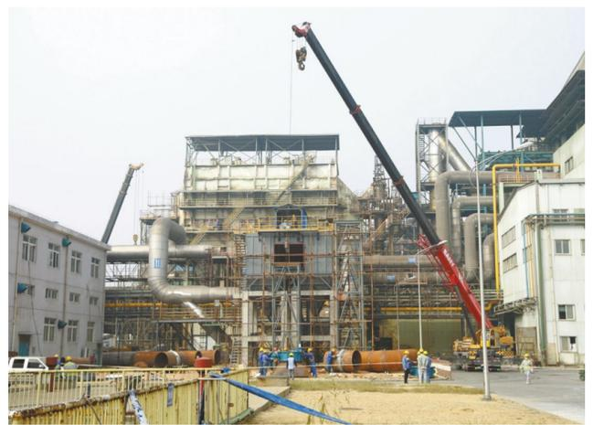
10月23日，铜冠建安安装公司职工正在金冠铜业大修中开展收尘系统吊装作业。在今年金冠铜业大修中，铜冠建安安装公司承担了总降区域电器、硫酸系统、选矿系统、缓冷场等59项大修项目。为做好承担的大修项目施工，安装公司于金冠铜业18日正式停产大修前一个星期就进场，做好了人员、设备集结和施工方案准备工作。目前，该公司所承担的项目正全面铺开，投入施工人员达140多人，预计月底将基本完成大修项目。
