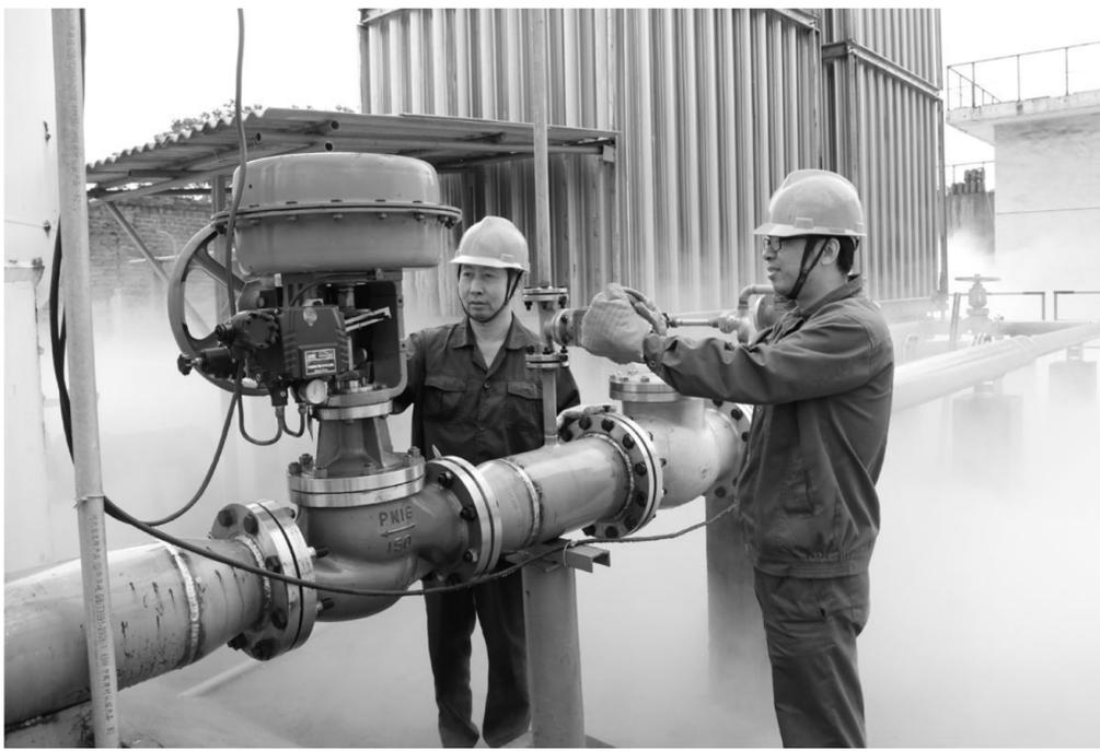
金昌冶炼厂制氧站职工目前正在巡查液氧汽化器运行状况。金昌冶炼厂针对制氧生产,在节能降耗上主动作为,将一期制氧系统关停,同时,通过新上2台液氧汽化器,弥补了制氧一期关停导致的氧气缺口。自7月份完成这项改造以来,不仅满足了奥炉生产的需要,更节约了能源。据测算,使用液氧汽化器替代制氧一期,运行1年可节约综合成本400多万元。王红平 齐宏明 摄
