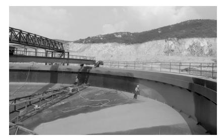
铜冠建安防水防腐公司在山东招金金合氰化尾渣资源综合利用工程施工过 程中,采取息人不息机的方式,提高劳动效率,确保工期和质量。图为该公司职工 对 38 米浓密机非标钢结构的内衬喷涂聚料进行防腐施工。陈 潇 吴帮华 摄
