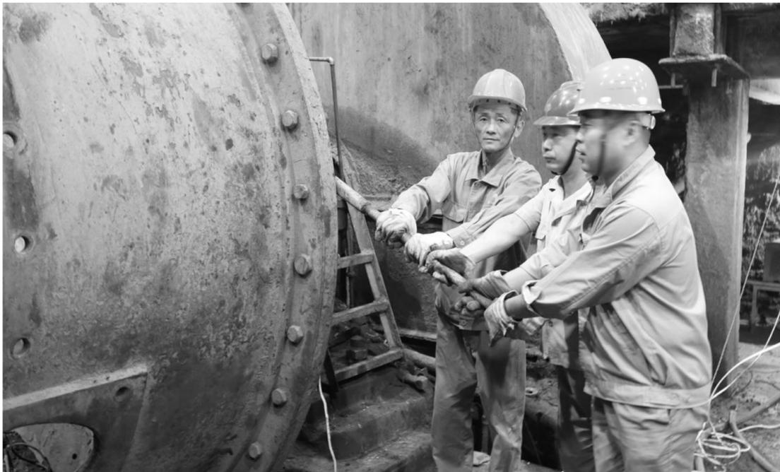
天马山矿业公司金口岭选矿车间职工国庆长假里正在检修球磨机。金口岭选矿车间针对设备状况,利用国庆长假,对节日期间生产和设备检修合理安排,一方面对处理炉渣的1号球磨机实行正常生产;另一方面,对处理自产矿的0号球磨机实行停产检修,全面更换衬板,较好地保证了国庆长假期间生产平稳过渡。 **王红平 叶玉芳 摄**
