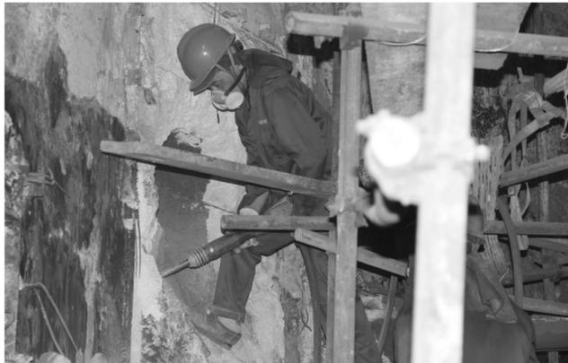
铜冠冶化分公司制酸二期是安徽省“861”计划项目,其项目关键设备沸腾炉,自2009年7月26日投产以来,已正常生产6年,炉体内耐火材料脱落严重,今年,该公司将其列为重点检修项目之一。由于炉内壁烧结物坚硬,维修人员只能用风镐对炉体内耐火材料和烧结物进行破碎,确保炉体安全和检修进度。图为维修人员清理烧结物场景。 **孙晓林 摄**
