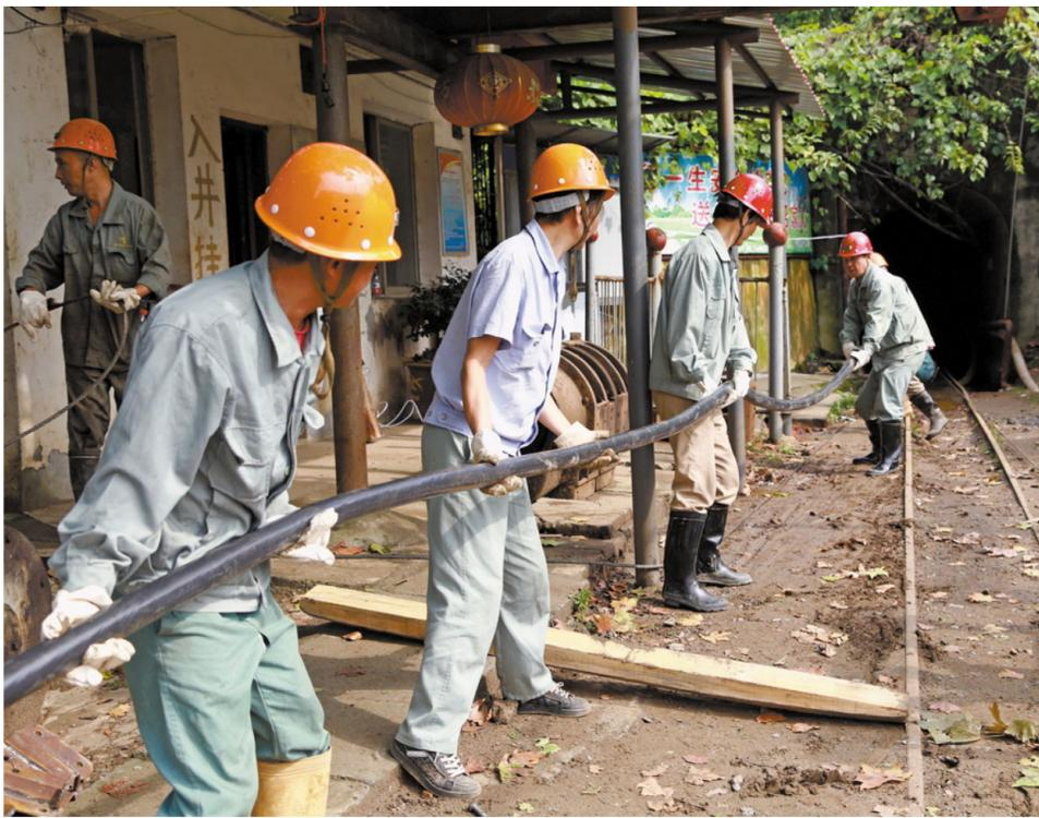
10月1日，天马山矿业公司毕东工区职工正在井口放电缆。为提高安全系数，更换毕东井下老旧电缆，天马山矿业公司毕东工区组织职工利用国庆放假时间铺设新电缆，电缆铺设工作从地表配电所开始，通过井口一直延伸到负130米和负171米两个中断，总长700多米。
