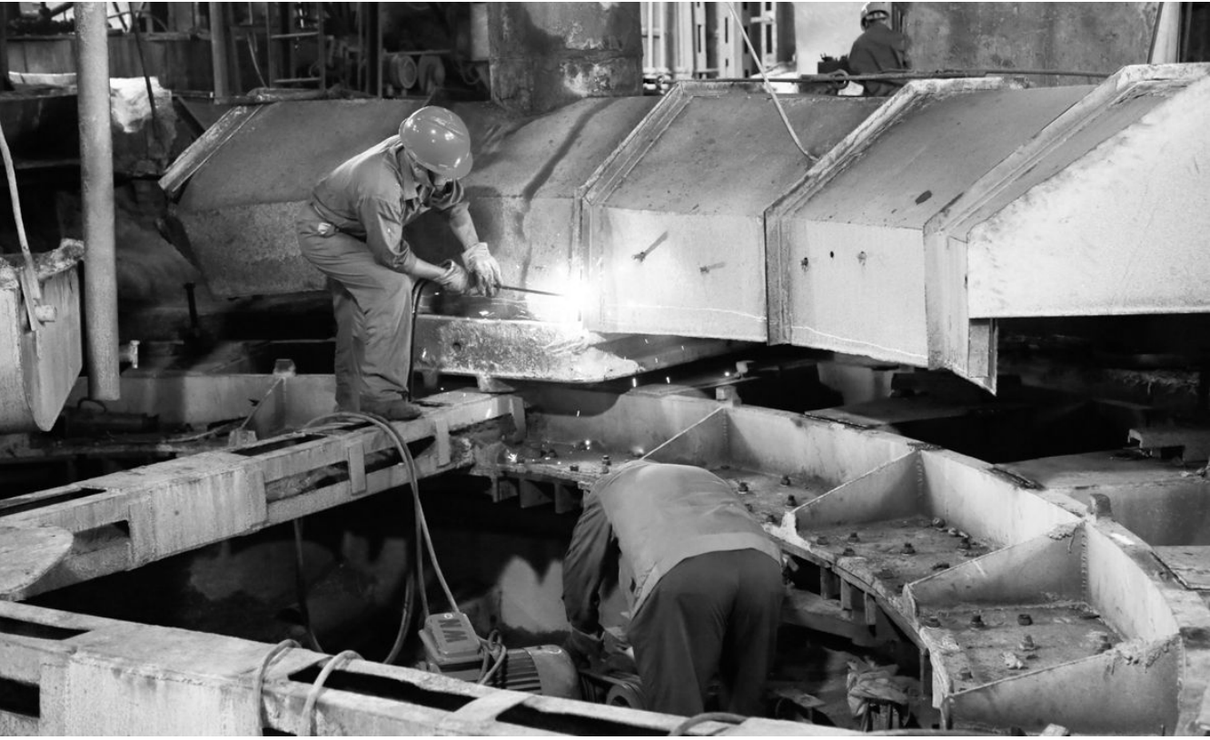
金昌冶炼厂熔炼车间职工正在维修圆盘浇铸机。为确保两节期间各项工作有序进行,金昌冶炼厂熔炼车间制定了《节日期间的安全生产注意事项》,对节日期间的生产、安全、设备、现场管理、治安综治等工作进行了详细布置落实,并加强设备维护保养,加大重点关键设备巡检力度,确保设备故障得到及时处理。 王红平 齐宏明 摄
