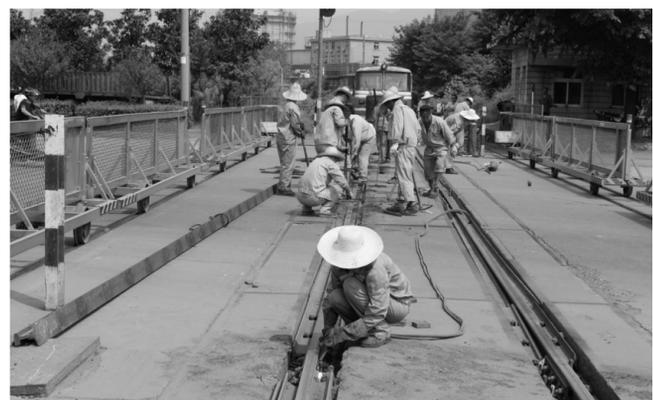
日前,铜冠物流金运分公司工务段近20名线路工放弃“双休日”时间,奋战在建华道口铁路线上抢修断裂钢轨。经过全力奋战,终于将断裂钢轨抢修完毕,保障了横港站至余家村站区间铁路专用线的安全畅通。
