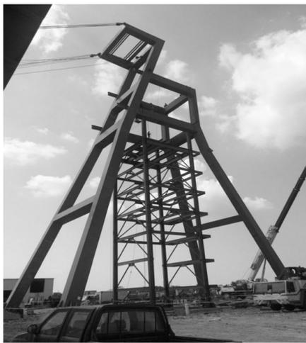
日前,铜冠矿业公司成功完成沙漠铜矿副井永久井架的吊装任务。该井架总重量352吨,总高度43米,是沙漠铜矿第一座永久井架。
