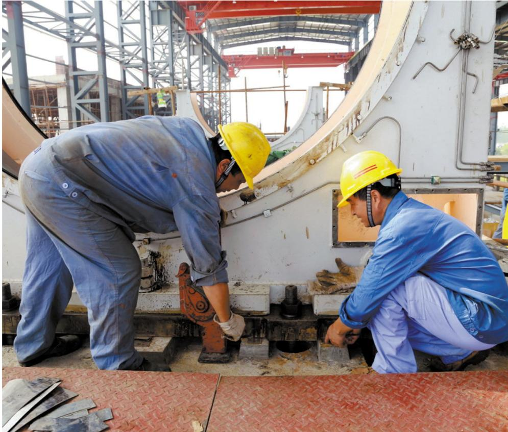
8月26日,铜冠建安安装公司职工正在安装半自磨主轴承底座。在沙漠矿业建设中,铜冠建安安装公司承担了磨浮车间两台大型设备的安装。其中,半自磨机直径8.5米,净重709吨;球磨机直径6.2米,净重832吨,均是集团公司磨浮系统中最大的设备。半自磨机自7月底开始安装,目前正在安装半自磨机主轴承底座,间距在7.6米的两个底座间横向中间线安装误差不能超过1毫米,安装精度要求极高。为确保精确度,该公司职工在安装底座中反复检测,不断调整,全力按设计要求做好施工。
