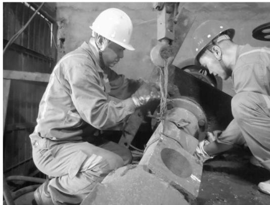
铜山矿业公司按照设备质量标准化要求，加强对设备的综合检修，确保设备安全运行。图为尾矿库管理车间维修工正在更换浮选机下体轴承。江君 张霞 摄
