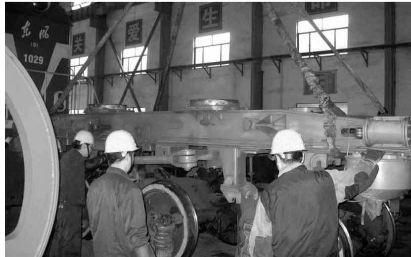
担负铜冠物流公司铁路运输的 DF51029 机车轮对因使用年久，轮缘磨损超限，导致该机车安全运用存在一定隐患。机辆分公司在没有专用不落轮镟修轮对车床的情况下，采取将机车走行部分彻底解体，逐个镟修轮对的办法，进行轮对镟修，经铁路部门专家验收符合过轨要求。
