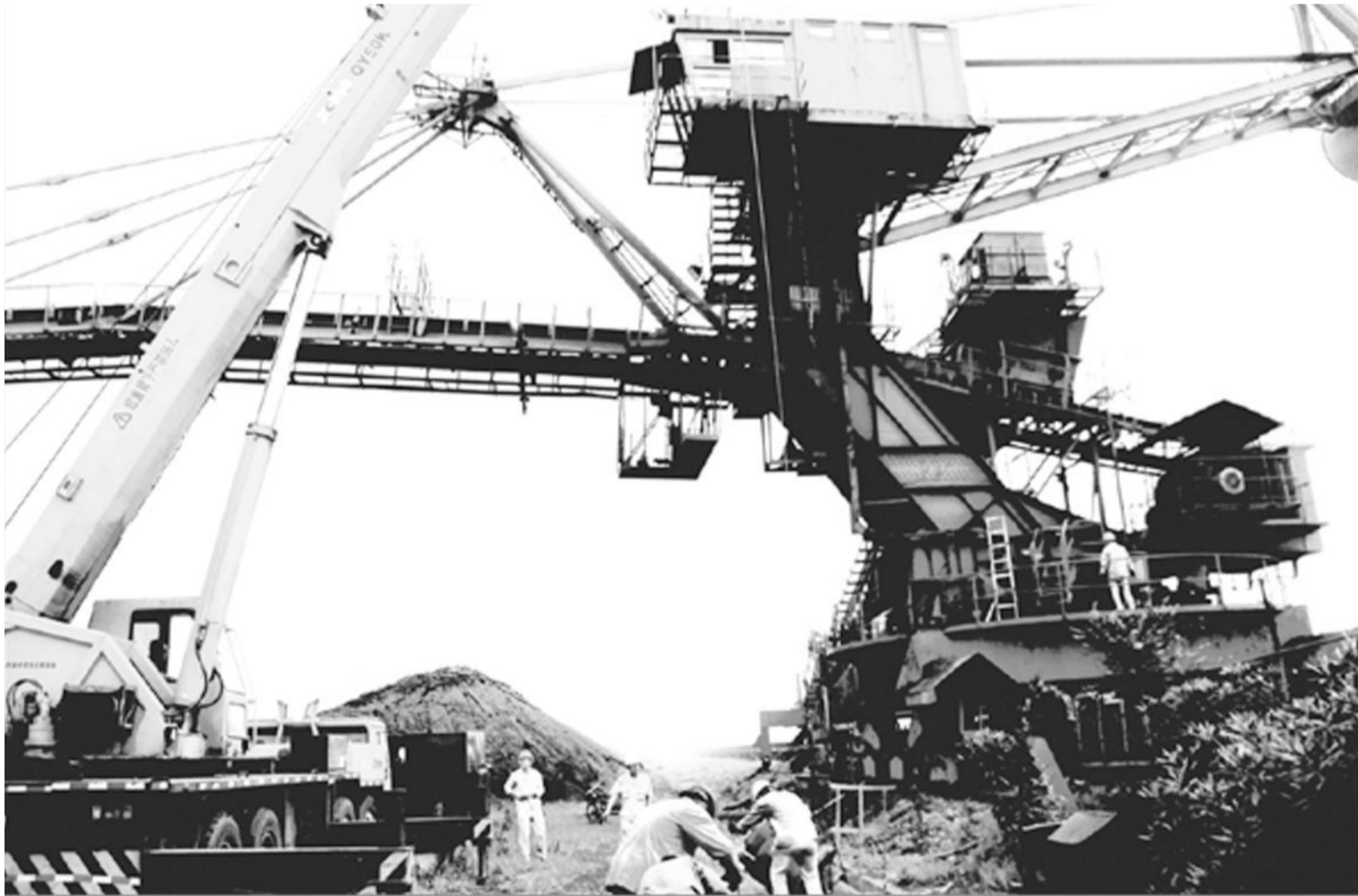
马钢港务原料总厂近日完成了港口1号桥机大修及部分设备改造项目,为生产顺利奠定了基础。图为该厂定修混二大型移动机。
