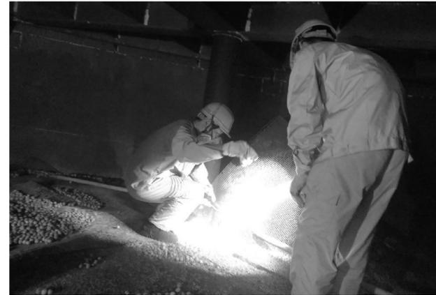
日前,为提升硫酸系统产能,铜冠冶化分公司硫酸车间在硫酸二期系统停车检修时抓紧对转化器触媒逐一扒松,并组织技术人员和生产骨干对触媒进行仔细检查(如图)。
